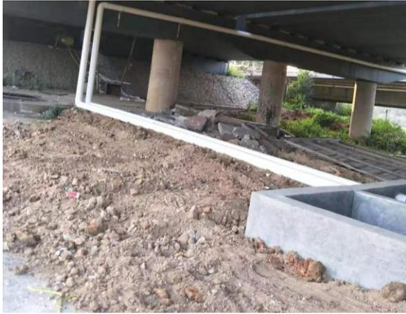
图 6.4-7 库竹大桥雷州方向隔油池
