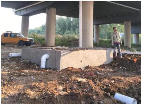
图 6.4-5 库竹大桥湛江方向隔油池
