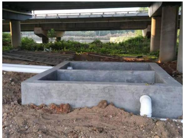
图 6.4-6 库竹大桥雷州方向隔油池
