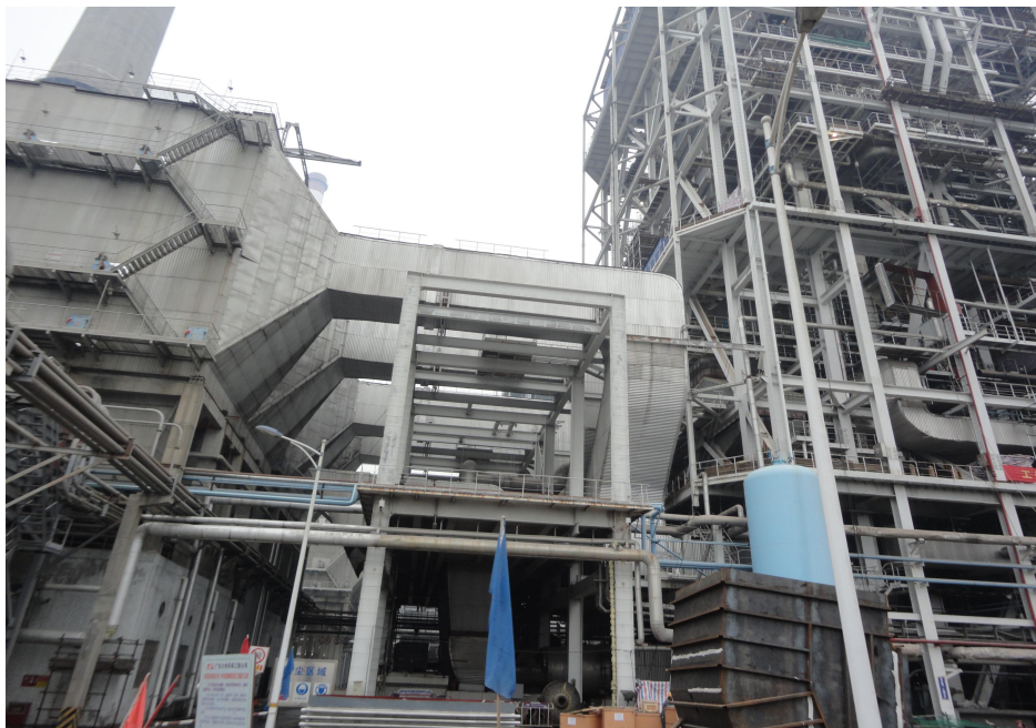
图 2.1-2 湛江电力有限公司锅炉现状
